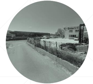
Entrées de ville dégradées
