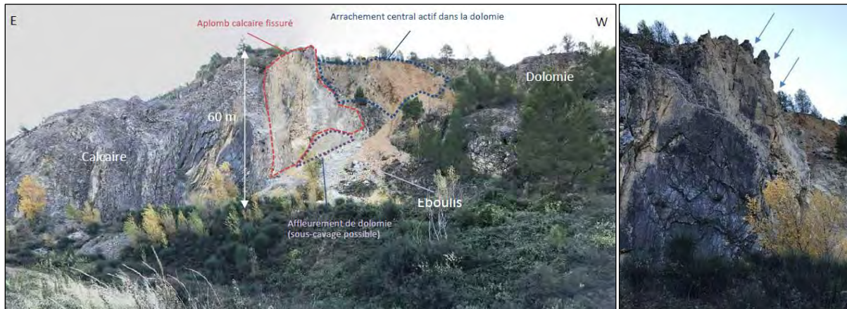
Figure 62. Arrachement central (à gauche) – Aplomb calcaire fissuré (à droite) (MICA Environnement)
