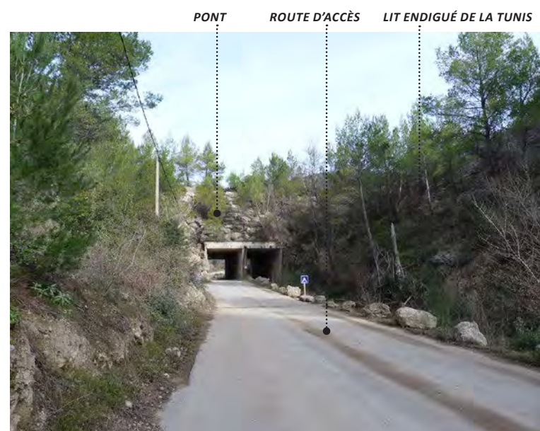
Vue 1 - Importants aménagements d'accessibilité / gestion des eaux
