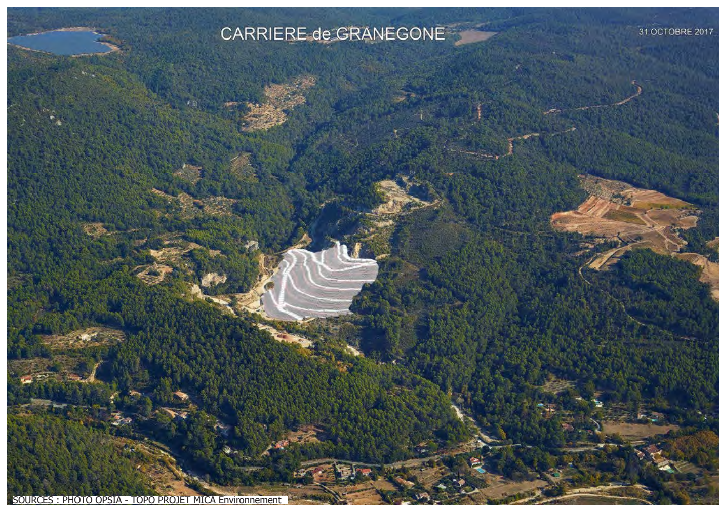
Incrustation 3D du projet initial établi par MICA Environnement sur vue aérienne oblique
