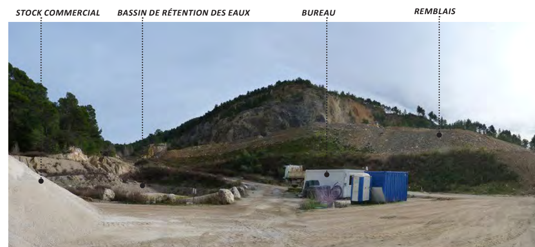
Vue 5 - Bassin de rétention des eaux de pluie sur le tracé du lit de la Tunis
