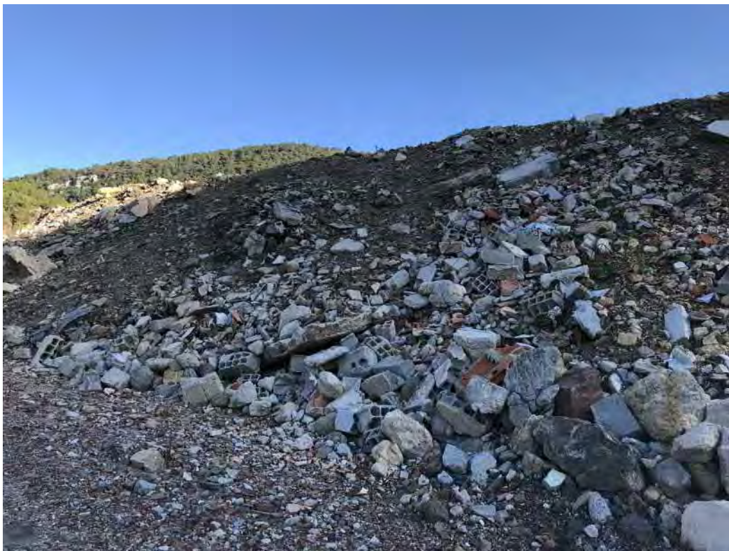
Figure 8 : Talus du stockage de matériaux inertes
