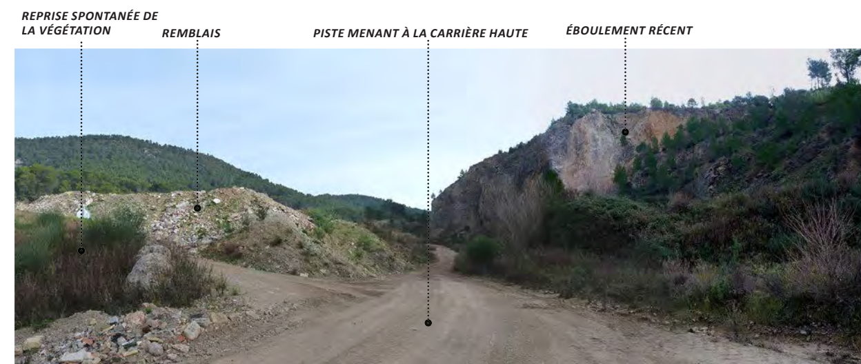
Vue 6 - Gestion de la stabilité en pied des fronts de la carrière basse
