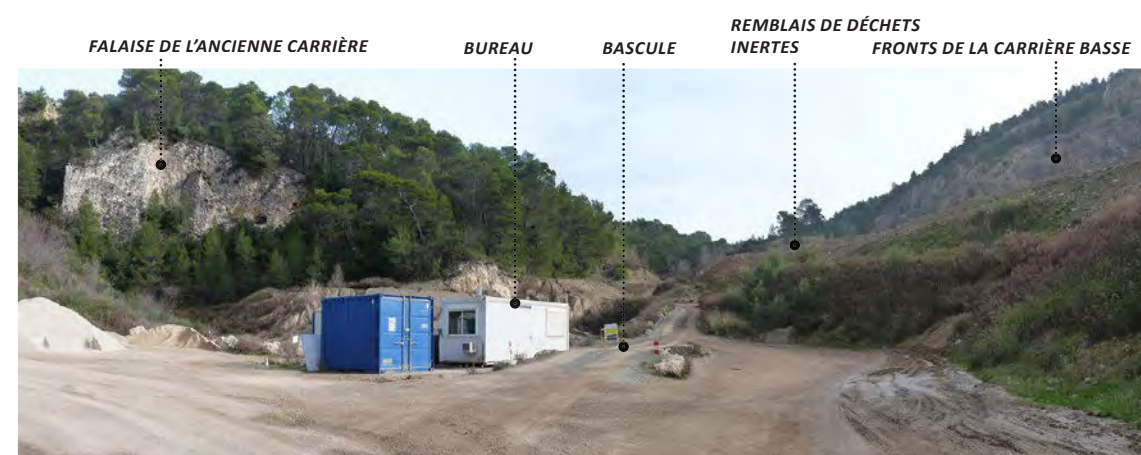
Vue 2 - Sobriété des aménagements bureau/bascule au sein d'un environnement minéral
