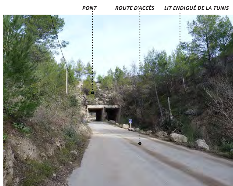
Vue 1 - Importants aménagements d'accessibilité / gestion des eaux
