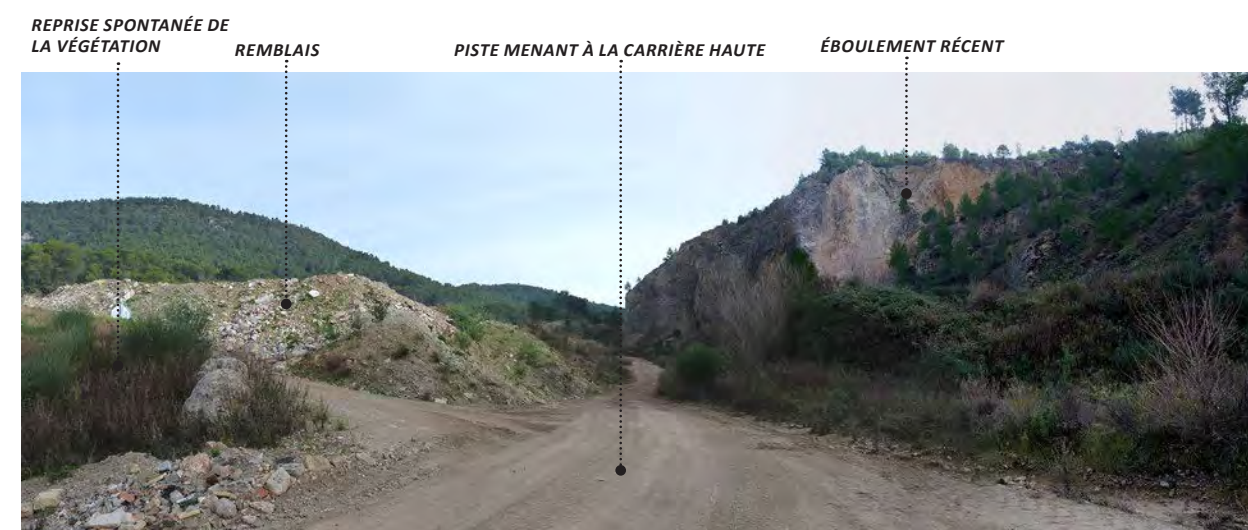
Vue 6 - Gestion de la stabilité en pied des fronts de la carrière basse
