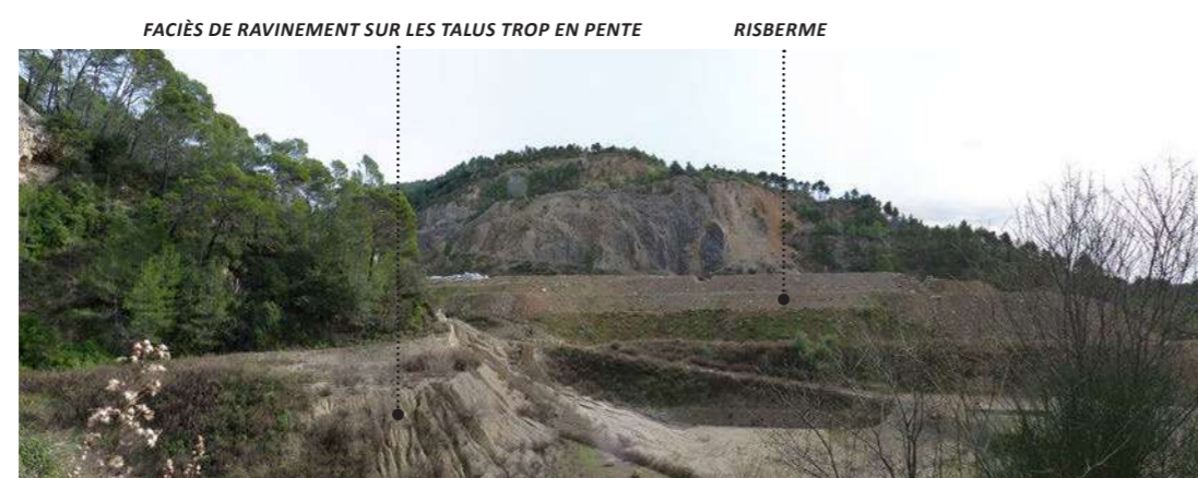
Vue 7 - Couches successives de remblais s'appuyant sur les fronts de la carrière basse
