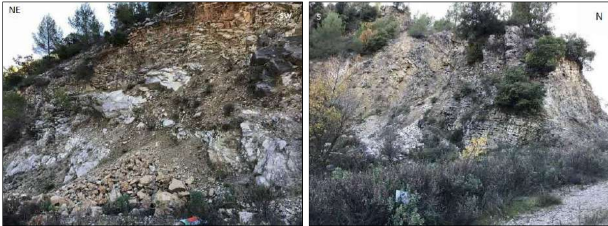
Figure 64. Zone d'éboulements liée à un pendage défavorable le long de la piste d'accès à la plateforme sommitale (à gauche) – Petits éboulements sur le flanc de la vallée sèche (à droite) (MICA Environnement)
