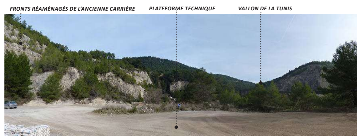
Vue 3 - Carreau de l'ancienne carrière converti en plateforme technique de valorisation des déchets inertes.
