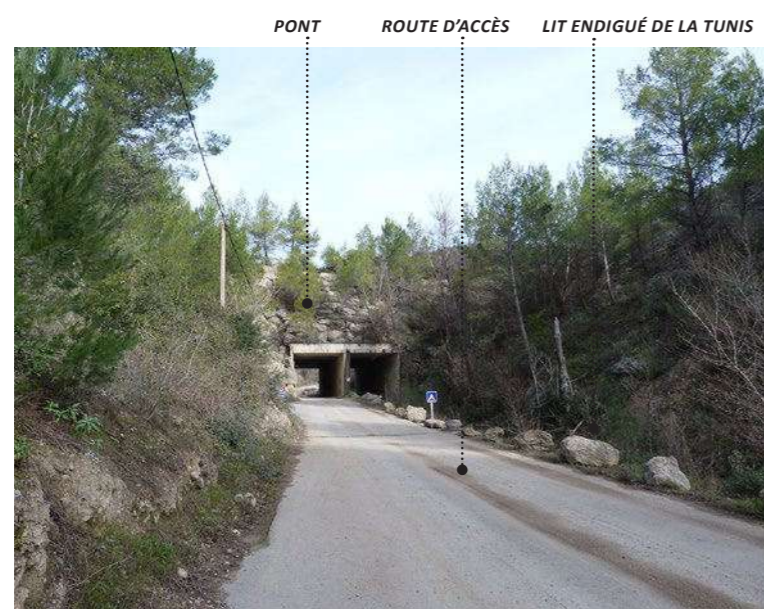
Vue 1 - Importants aménagements d'accessibilité / gestion des eaux
