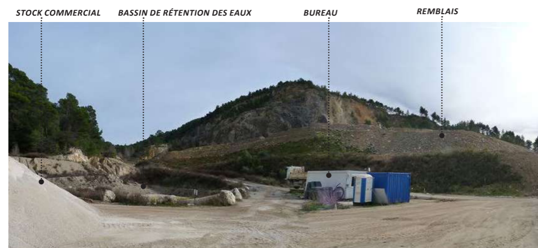
Vue 5 - Bassin de rétention des eaux de pluie sur le tracé du lit de la Tunis
