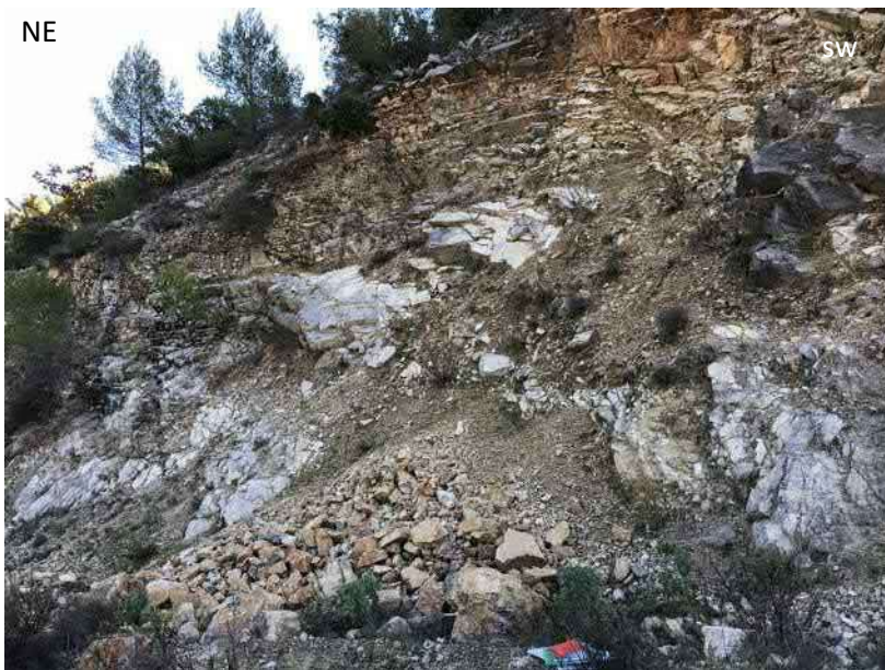
Figure 22 : Zone d'éboulements liée à un pendage défavorable le long de la piste d'accès à la plate-forme sommitale
