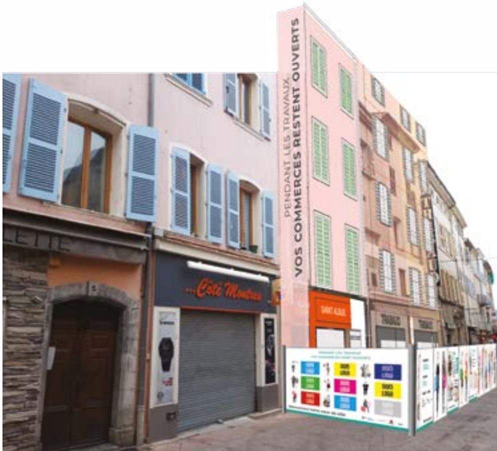
Palissade avec échafaudage + porte accès chantier Rue Cisson vers Place Cassin
